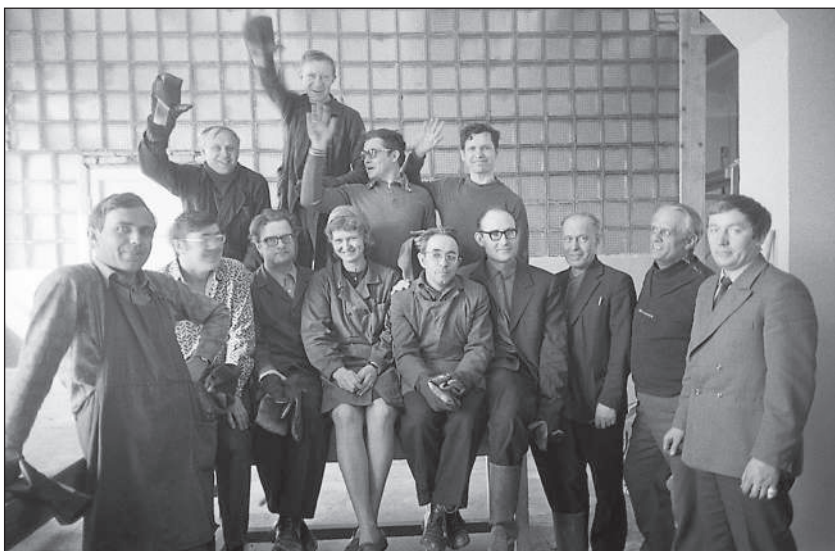
Субботник на строительстве Челябинского дома печати.
