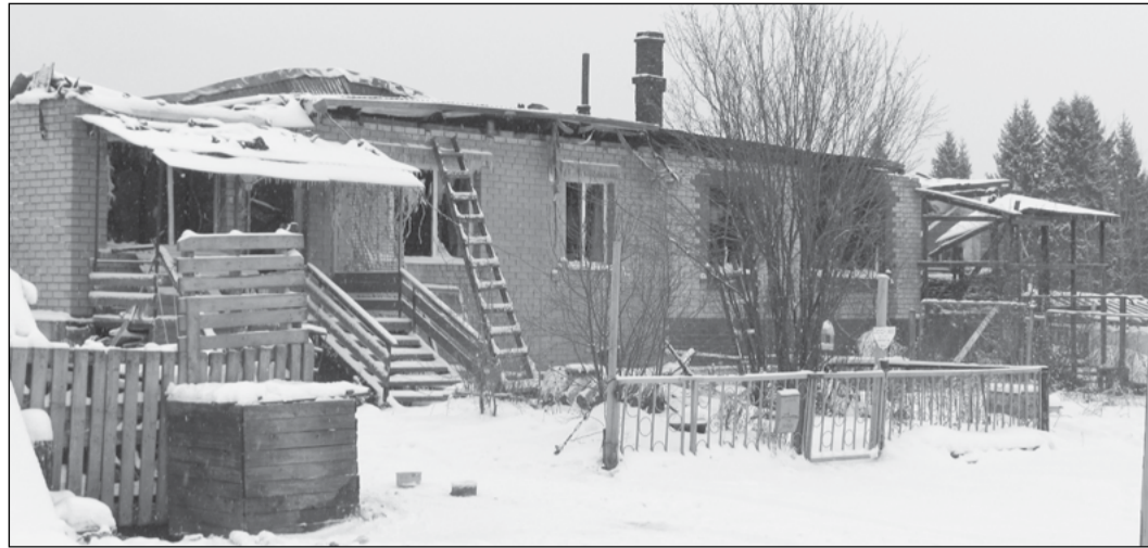
После пожара по ул. Майской в двухквартирном доме уцелели лишь стены, но жить в нём невозможно.
