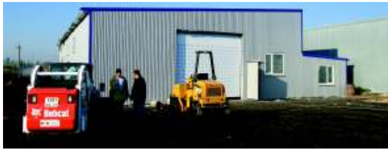
Новая теплая ремонтная база ИП Довженко общей площадью 400 квадратных метров для обслуживания автотранспорта почти готова.
