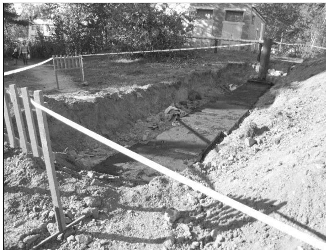
Около детсада № 13 построен новый участок теплотрассы. / Фото Ларисы Широких
