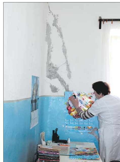
Трещины в детской регистратуре заделаны монтажной пеной.
