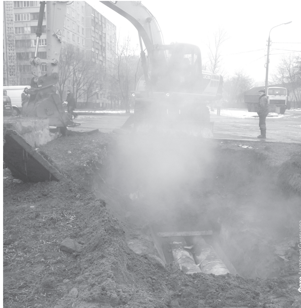
Место разрыва теплосети на ул. Магистральной
