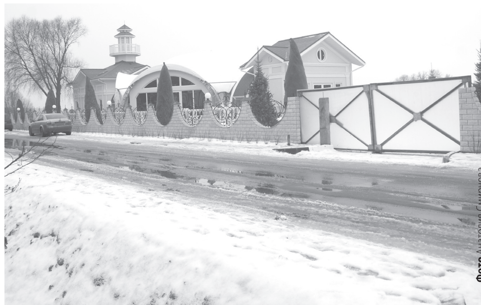
Строительство ресторана на береговой полосе
