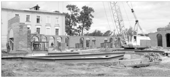
Строительство ресторана на улице Орлова (в строгой охранной зоне) идет полным ходом.
